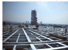
ヘリポート鉄骨建方
