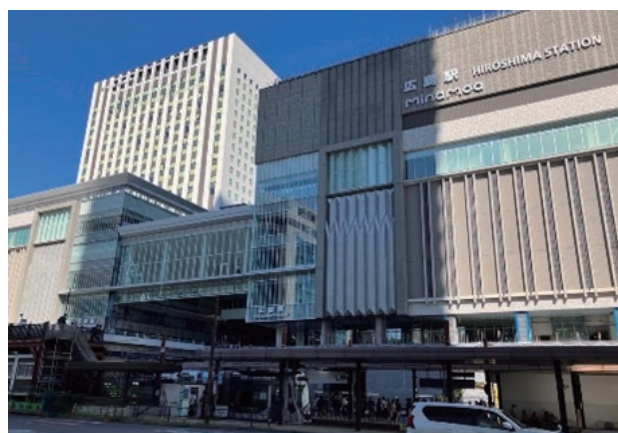
完成間近に訪れた時の写真（左：西棟、右：東棟）
