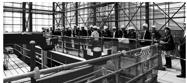
工事現場見学会 (平城宮跡大極殿院東楼復原工事)
