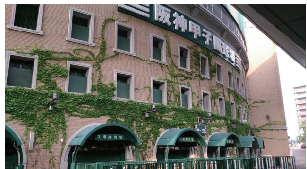
2010 年改修の甲子園球場は、蔦がずいぶん伸びてきました。
