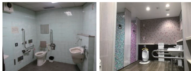
東山公園駅のトイレ (左：改修前、右：改修後)
