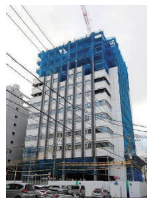
名港ビルディング建替プロジェクト外観
