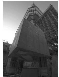
既設基礎の撤去状況
