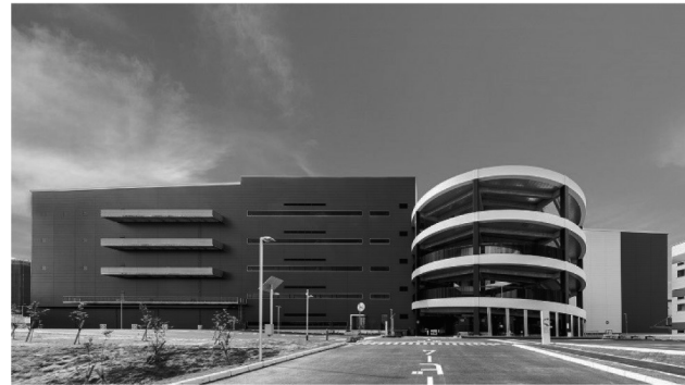
写真：某物流倉庫竣工写真
