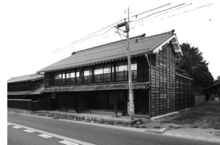
小野家住宅主屋(竣工後)
