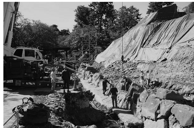
弘前城本丸石垣解体修理中
