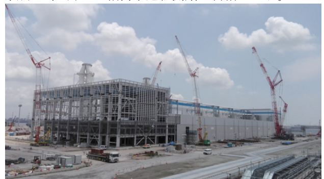
建設中の本館建屋 (手前) と煙突2基 (奥)
